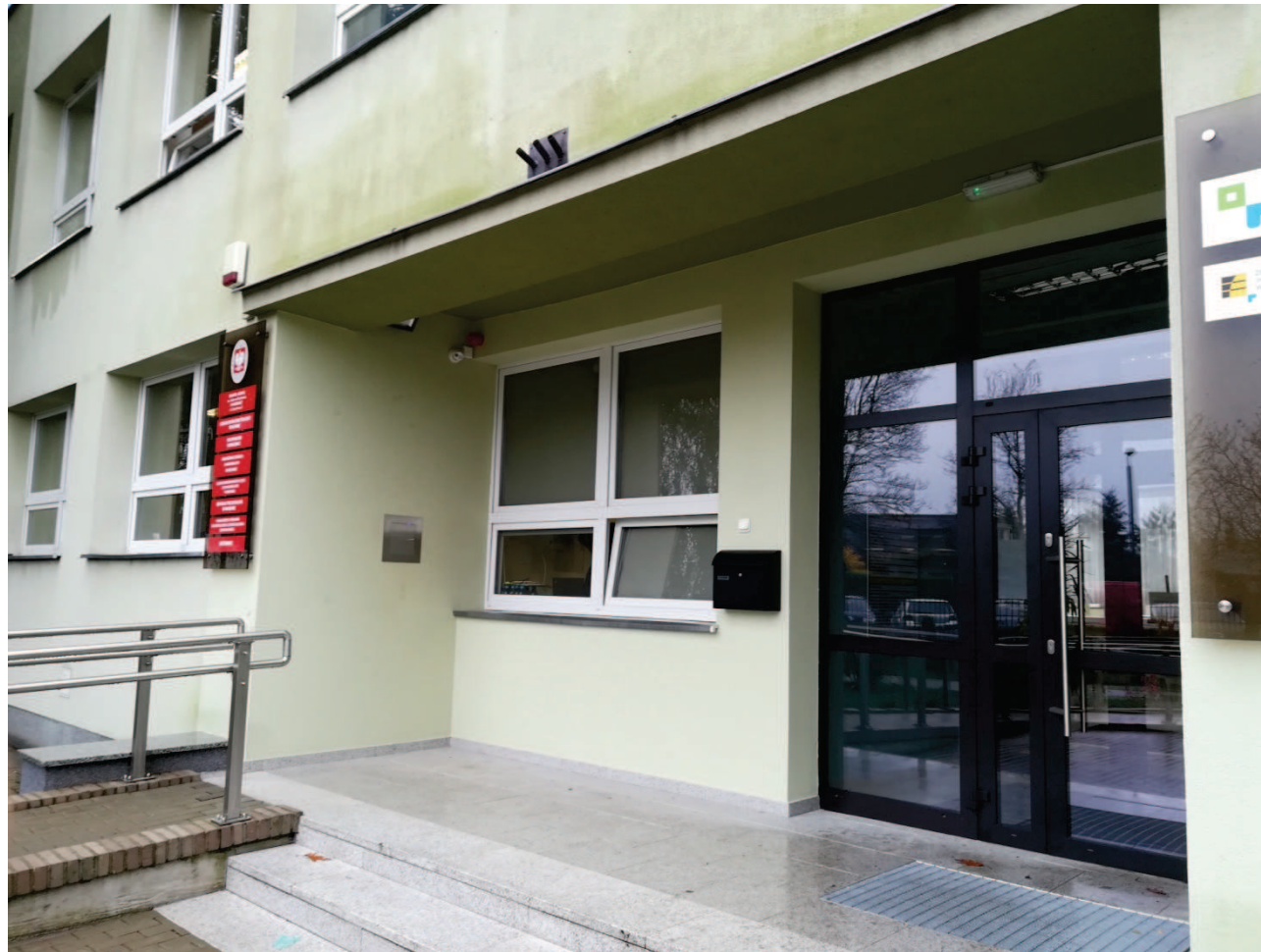
Kaseta Straży Pożarnej wmontowana w elewację budynku
