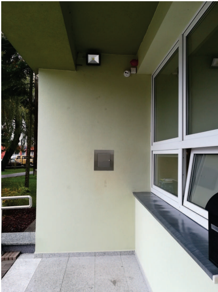
Kaseta Straży Pożarnej wmontowana w elewację budynku
